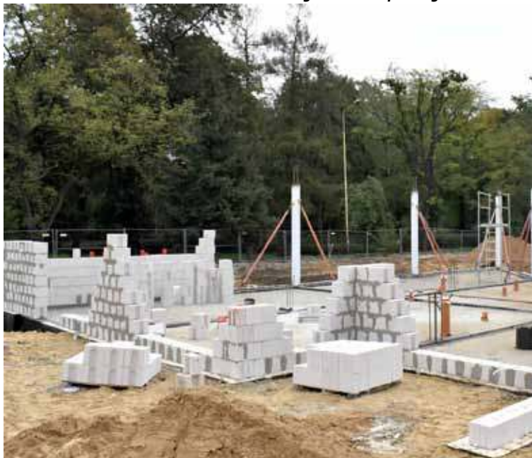
Widać już fundamenty i fragmenty ścian budynku socjalno-biurowo-usługowego.
