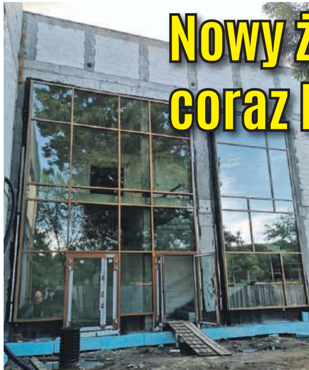
Żłobek budowany jest w nowoczesnym stylu
