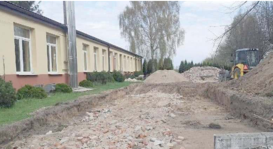
Wnętrza placówki zostaną wykonane od podstaw, zmieni się również teren wokół budynku
