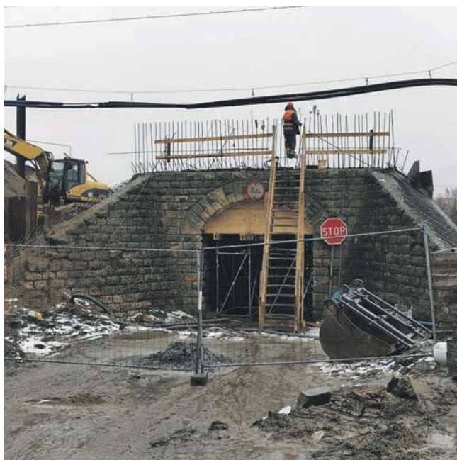
Wiadukt nad ul. Krasickiego
