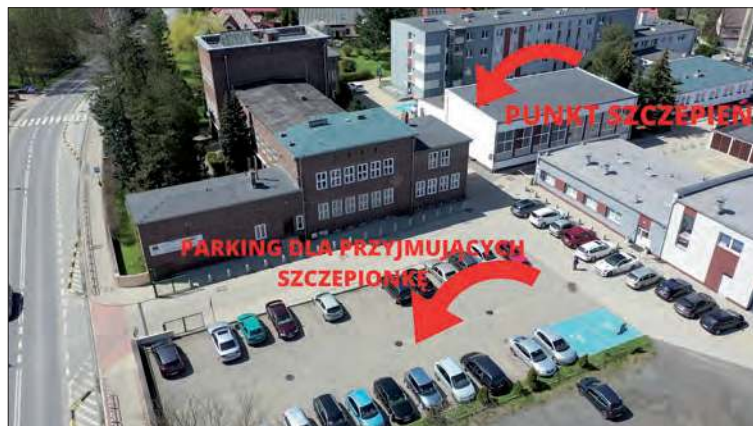
Lokalizacja Powszechnego Punktu Szczepień oraz parkingu
