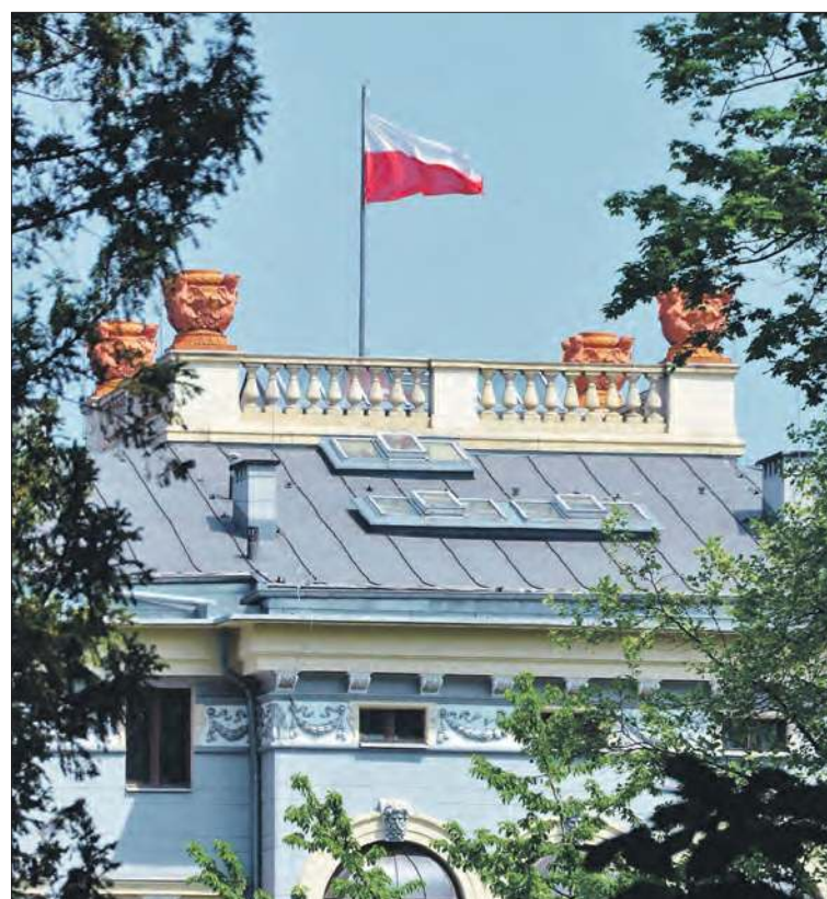
Flaga państwowa na maszcie siedziby Prudnickiego Ośrodka Kultury
