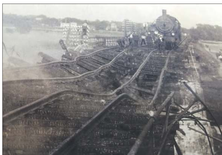
Zniszczony most na Odrze
