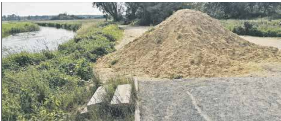
Tak wyglądała inwestycja nad Krzną na wysokości ul. Żurawiej na miesiąc przed wyznaczonym terminem jej zakończenia
