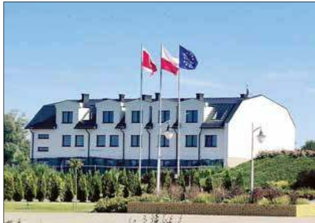
Finalizowana jest budowa przychodni w gminie Terespol, to budynek sąsiadujący z urzędem gminy, znajdującym się w Kobylanach. Termin wykonania jest określony na 30 września
