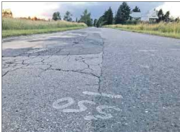
Gmina Łomazy poinformowała w tym tygodniu, że jeszcze w tym roku wspólnie z powiatem bialskim zostanie wykonany remont drogi powiatowej, biegnącej z Łomaz do Jusaków-Zarzeki
