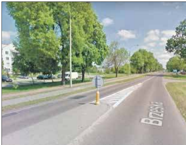
Nowa nawierzchnia bitumiczna na ulicy Brzeskiej pojawi się na blisko 2-kilometrowym odcinku od sklepu „Stokrotka” do granicy miasta
