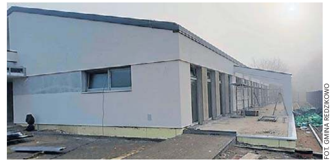
Budowa żłobka w Głobinie zmierza do końca
