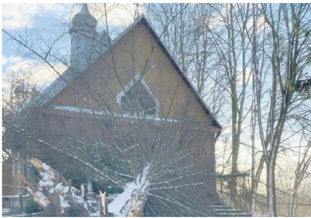
W Strzyżowie przewrócone przez wiatr drzewo runęło na schody przed wejściem do kościoła.
