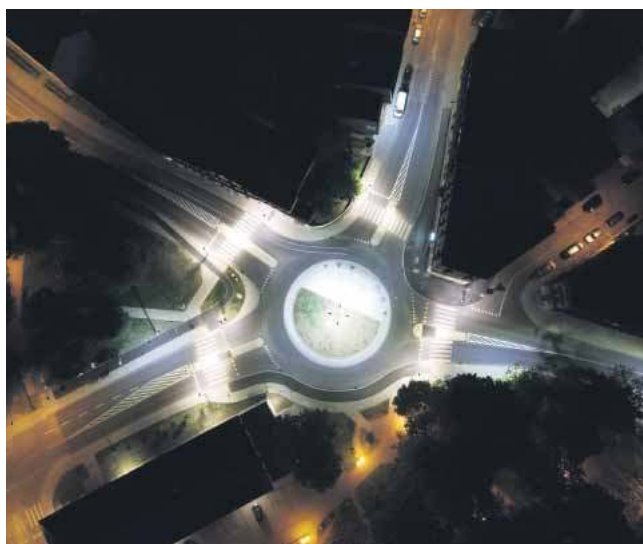
Zaletą przebudowy jest na pewno nowe oświetlenie. Na skrzyżowaniach, gdzie wybudowano ronda, poprawiła się też płynność ruchu
