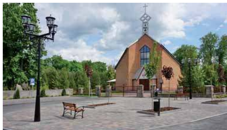
Przy kościele utwardzono nawierzchnię dróg manewrowych, ułożono chodniki z kostki brukowej oraz utwardzono miejsca parkingowe
