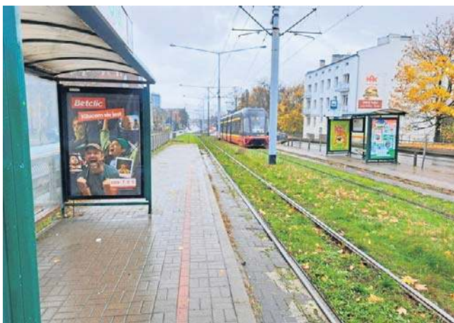
Projekt wyburzenia wiaduktu tramwajowego spotkał się z wieloma krytycznymi opiniami
