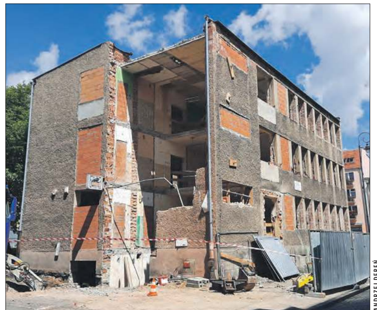
Biurowiec w przebudowie
