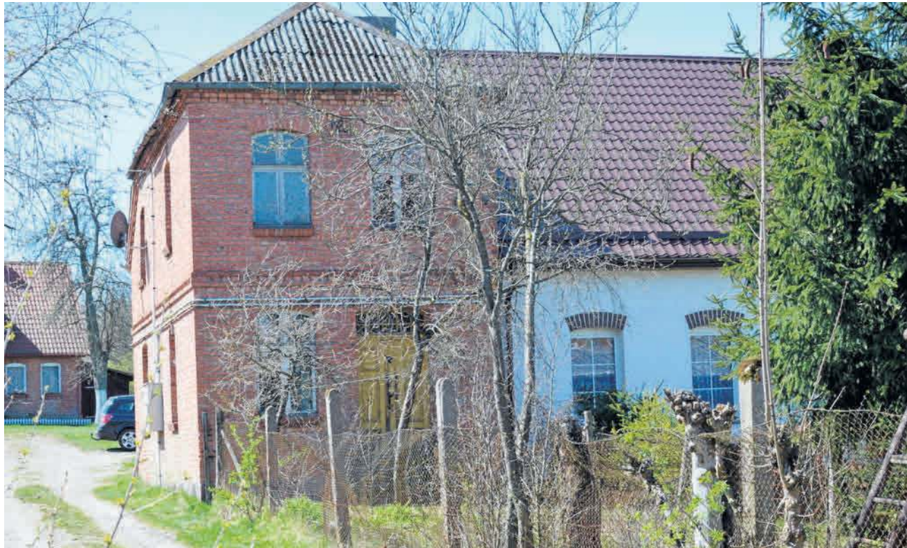
Dom Leszka Pękalskiego (cegłana część) został wyceniony na 39 tys. zł
