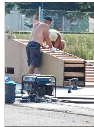
Obecnie trwa montaż urządzeń.
