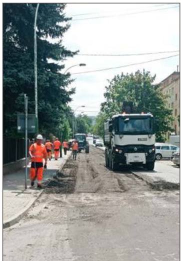
Obecnie prace prowadzone są m.in. przy ul. Sobieskiego.
