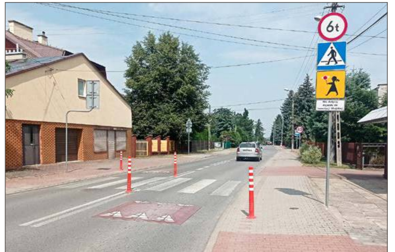
Pasy już co prawda wytarte, ale progi, słupki i inne oznaczenia są.
