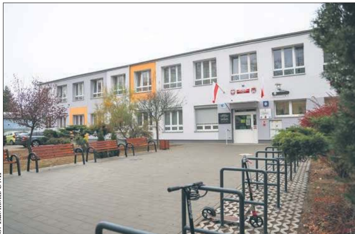
Zakończyła się termomodernizacja płockiej Jedenastki
