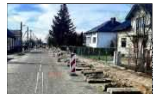
Trwa przebudowa ulicy Spółdzielczej w Kodniu
