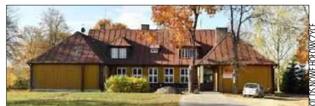
Remont przejdzie też budynek Dziennego Domu Seniora+ w Hołowczycach
