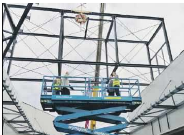
Zakończenie pierwszego etapu budowy uhonorowano tzw. zawieszeniem wiechy w najwyższym punkcie konstrukcji
