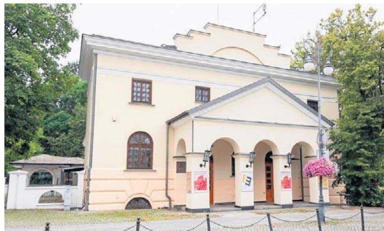
Zabytkowa Łaźnia w Radomiu przeszła wielki remont. Zmodernizowano wnętrze, ale także elewację zewnętrzną.
