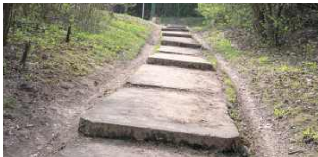
Tak schody wyglądały kilkanaście dni temu
