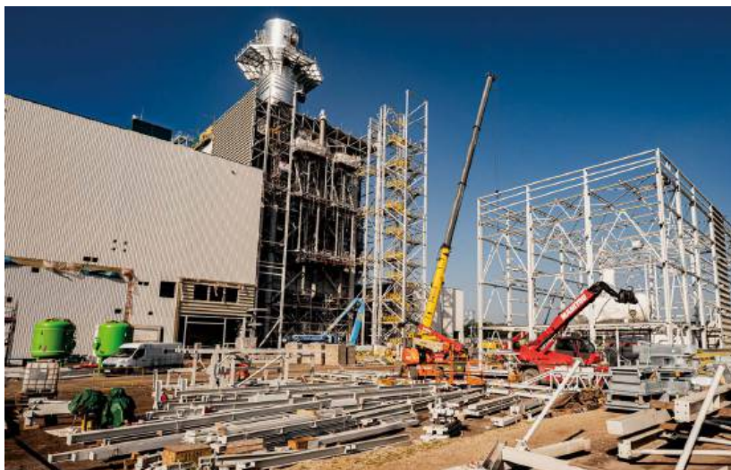
Budowany blok parowo-gazowy PGE Nowy Rybnik
