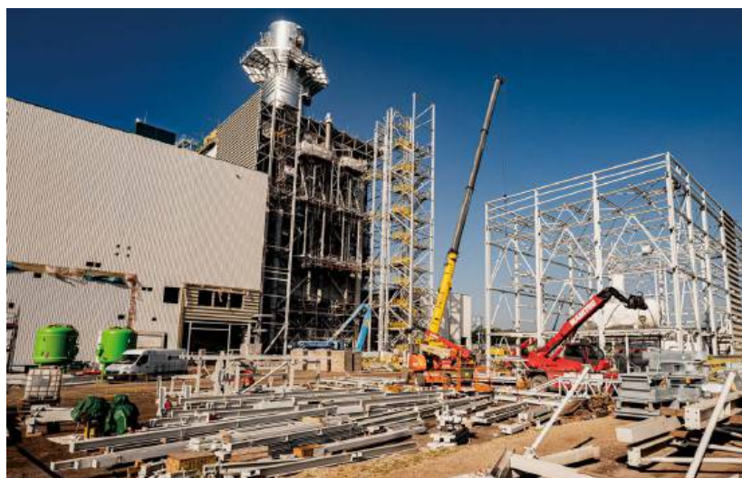
Budowany blok parowo-gazowy PGE Nowy Rybnik
