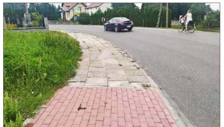
Chodnik został częściowo wyremontowany przez powiat. Kolejnym odcinkiem, być może jeszcze sierpniu, zajmie się miasto.
