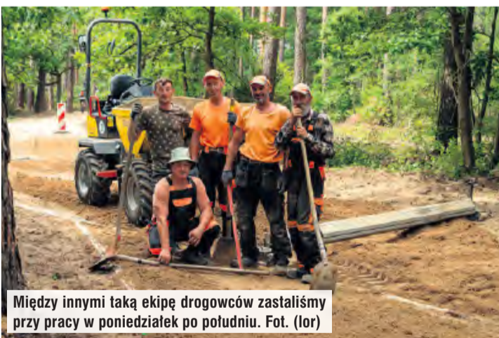
Przygotowania do montażu murów oporowych. Fot. (lor)
