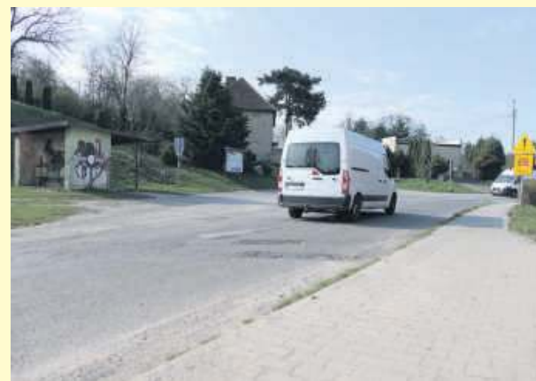
Remont tej drogi powiatowej uzyskał dofinansowanie
