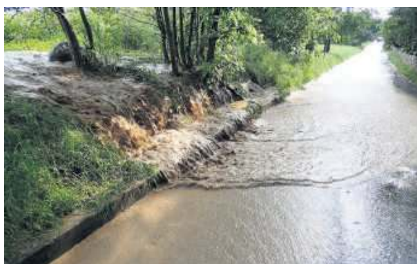
W czerwcu ubiegłego roku po intensywnych opadach deszczu z pól przy ulicy Górzystej w Strzelinie na drogę spływały ogromne ilości wody z błotem i kamieniami. Fot. archiwum Słowa Regionu
