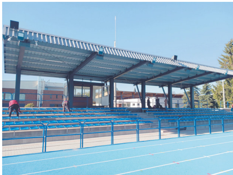
Część trybun już pod dachem
