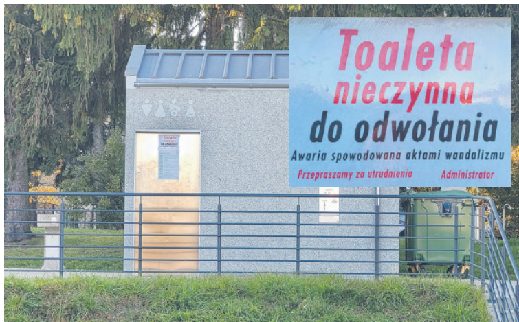
Zniszczona toaleta przy Centrum Sportów Miejskich
