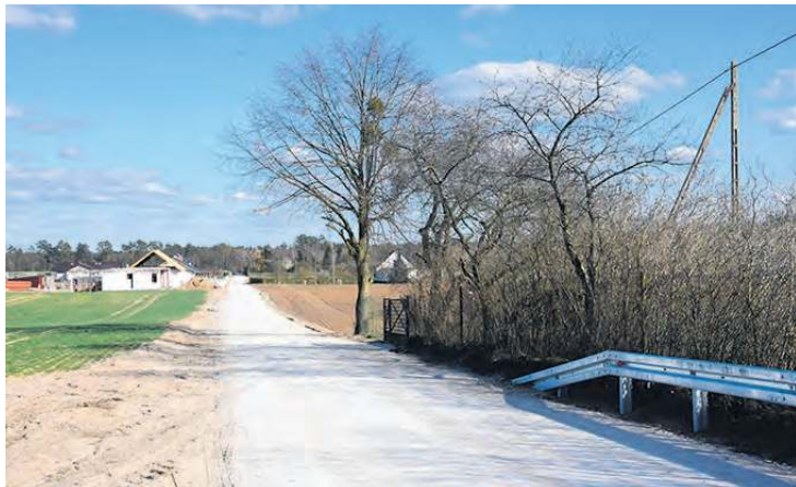
Nowo wybudowana droga Łyskowo – Świt. Gdyby przy niej od razu powstał rów odwadniający, nie byłoby problemu z zalewaniem działek.
