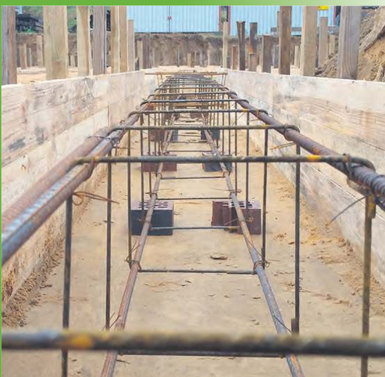
Zbrojenie ław. Fot. nadesłane
