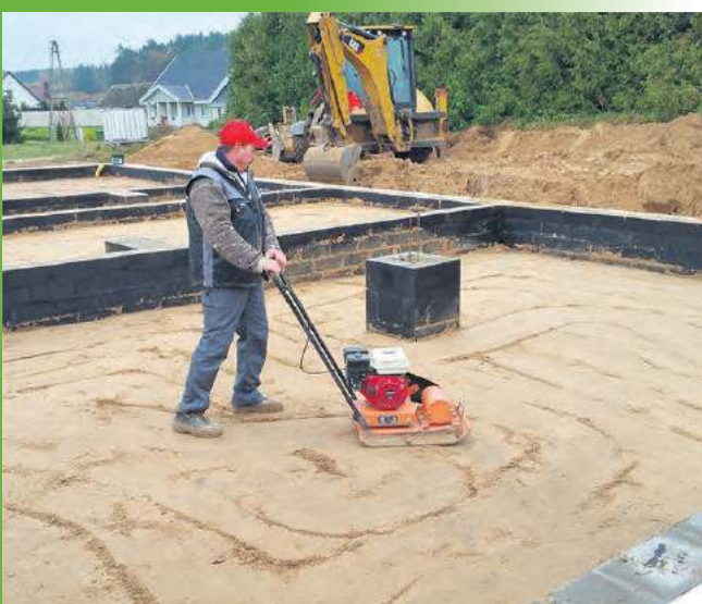
Zagęszczanie warstw piasku między ławami. Budowlancy korzystają z odpowiedniego sprzętu. Fot. nadesłane
