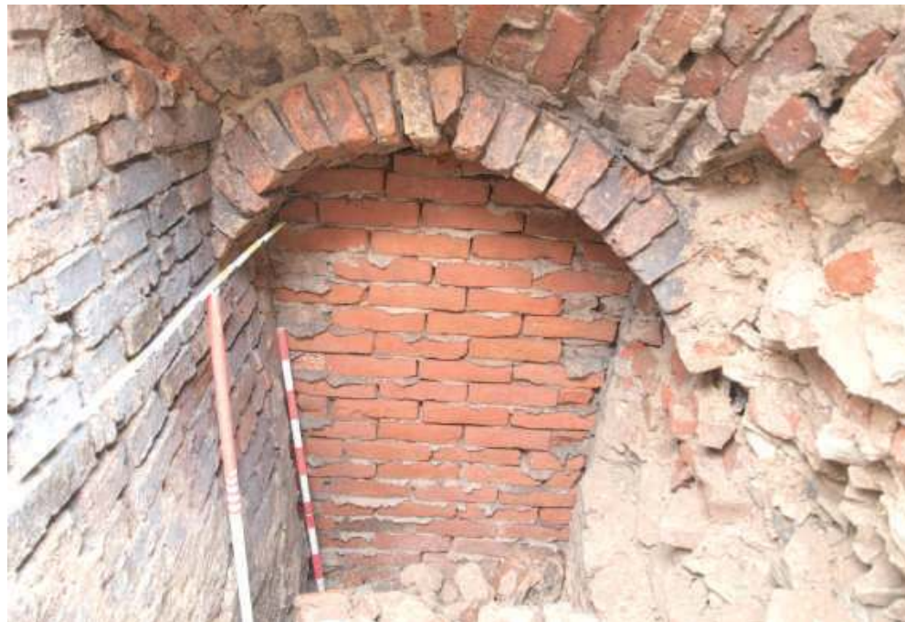
Wykop budowlany z widocznym otworem w miejscu załamania sklepienia
