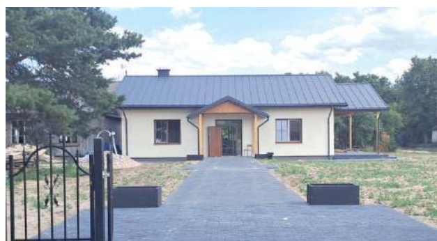
Według projektu w Węgielcach ma powstać budynek o powierzchni około 100 m 2 z zapleczem sanitarnym i kuchennym przystosowany dla osób niepełnosprawnych. Aktualnie prace związane z budową świetlicy są na półmetku
