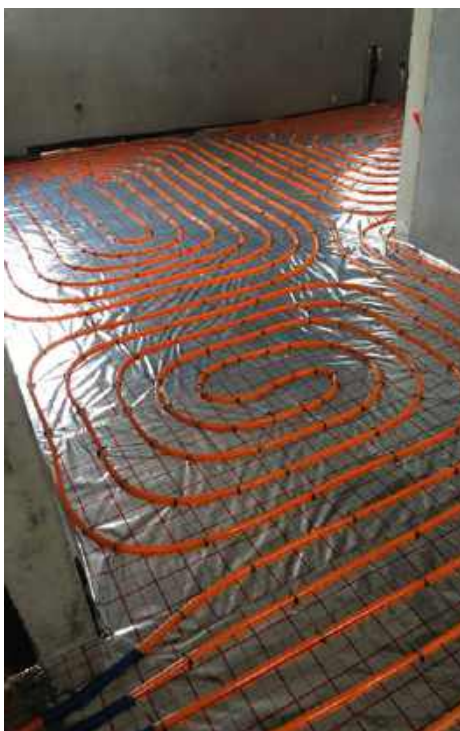
❷ Najlepsze źródło górne to niskotemperaturowe ogrzewanie płaszczyznowe, czyli np. podłógówka. RWC
