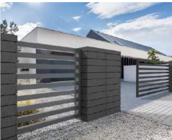
📍 Słupki między ogrodzeniami panelowymi mogą być wykonane z bloczków betonowych ułożonych w dwóch rzędach, co daje wrażenie prywatności i nowoczesności. FORBET
