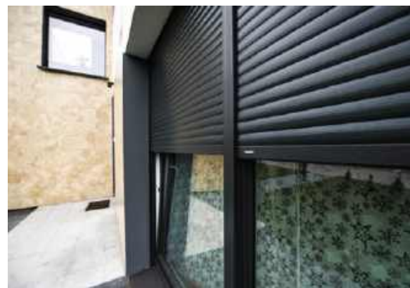
📌 Rolety podtynkowe z zabudowaną, niewidoczną kasetą. KRISHOME
