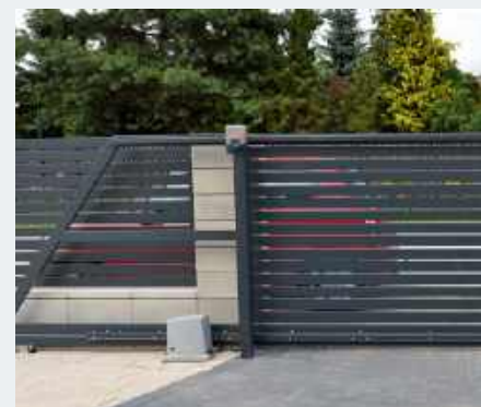
🔧 Postument pod centralą sterującą obudowano brukiem.
