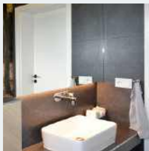
❷ Tylko w łazience dla gości założono podtynkową wersję baterii umywalkowej. eprasa.pl 0e255a97f9
