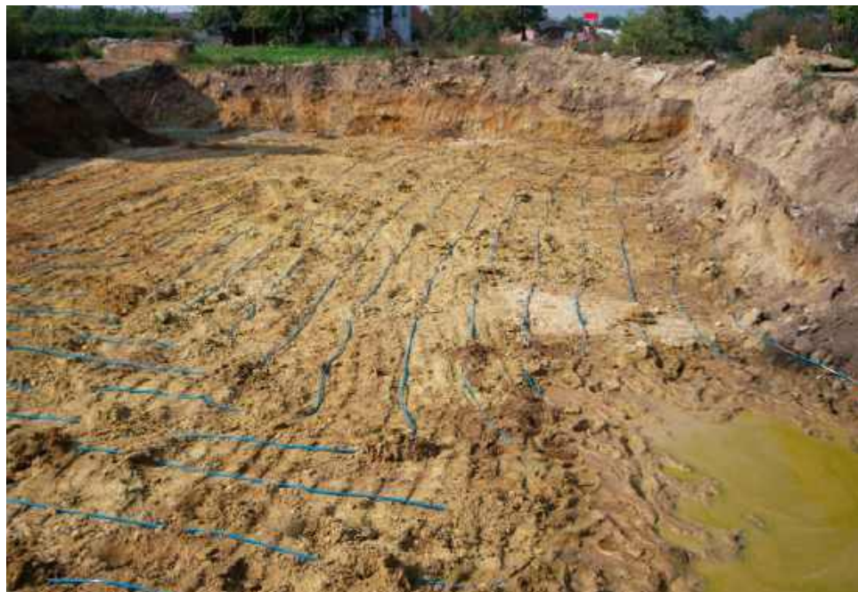
❶ Wykop pod poziomy kolektor gruntowy. CLIMA KOMFORT
