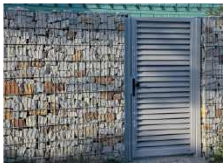
📍 Gabiony, czyli druciane kosze wypełnione różnego rodzaju materiałem, np. kamieniami. Doskonale sprawdzają się przy ruchliwej drodze, bo stanowią solidne zabezpieczenie przed hałasem i wzrokiem innych. BETAFENCE
