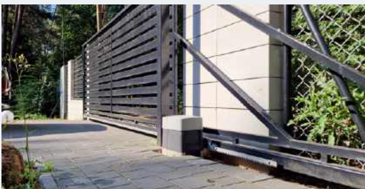
Markowy napęd zamontowała ekipa zajmująca się systemami alarmowymi.
