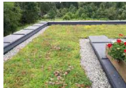
📍 Stropodach zielony stanowi powierzchnię biologicznie czynną. BMI ICOPAL, T. RYBARCZYK
