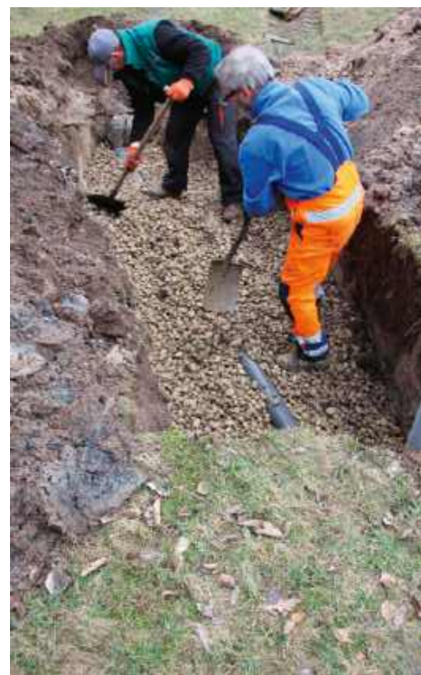
● Obsypanie rur żwirem lub tłuczniem to standard. Jednak może być potrzebna wymiana dość grubej warstwy gruntu pod nimi. J. WERNER
