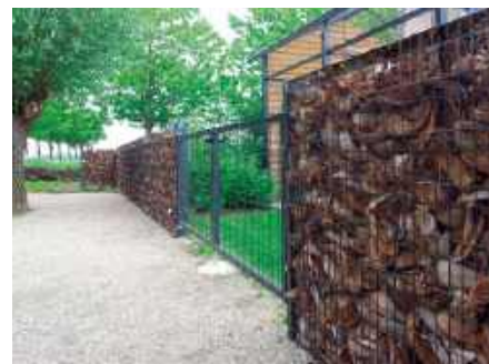
📍 Gabiony wypełnione korą są mniej popularne, ale równie ekologiczne jak te, w których głównym budulcem jest kamień. Bardzo dobrze wpasowują się w naturalny krajobraz. BETAFENCE
