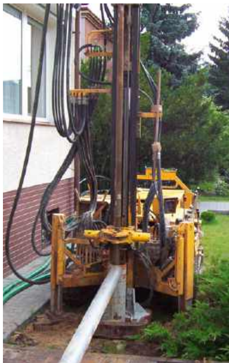
❶ Odwiert pod wymiennik pionowy. NIBE-BIAWAR
