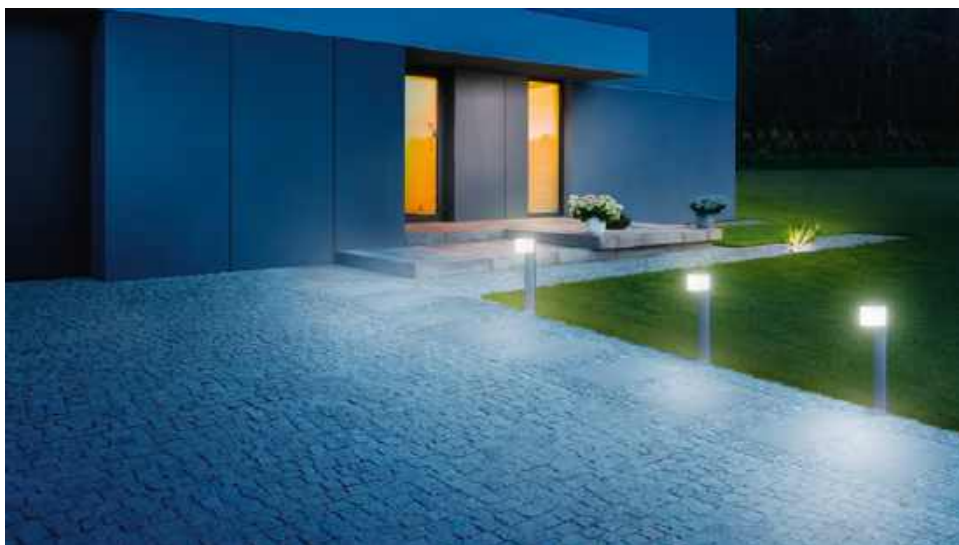
🔦 Lampy słupki, podświetlające ścieżkę prowadzącą do domu. STEINEL (LANGE ŁUKASZUK)
