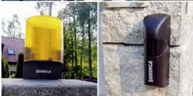
🔧 Automatyka do bram wjazdowych to nie tylko siłowniki, ale też lampka sygnalizująca pracę napędu oraz fotokomórka, zatrzymująca ruch bramy, gdy napotka przeszkodę. BENINCA
