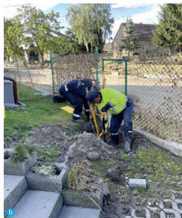
❶ Ekipa Polskiej Spółki Gazownictwa w trakcie pracy nad przywróceniem dostaw gazu w gminie Głuchołazy. Obciążanie gazociągu wymytego przez wodę (a) i montaż nowej skrzynki gazowej (b) – poprzednią zabrała woda. POLSKA SPÓŁKA GAZOWNICTWA
