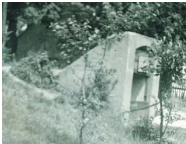
Wejście do schronu na placu Jedności Narodowej (lata 50.) - obecnie to plac Piłsudskiego, miejsce tuż obok Pomnika Losów Ojczyzny
