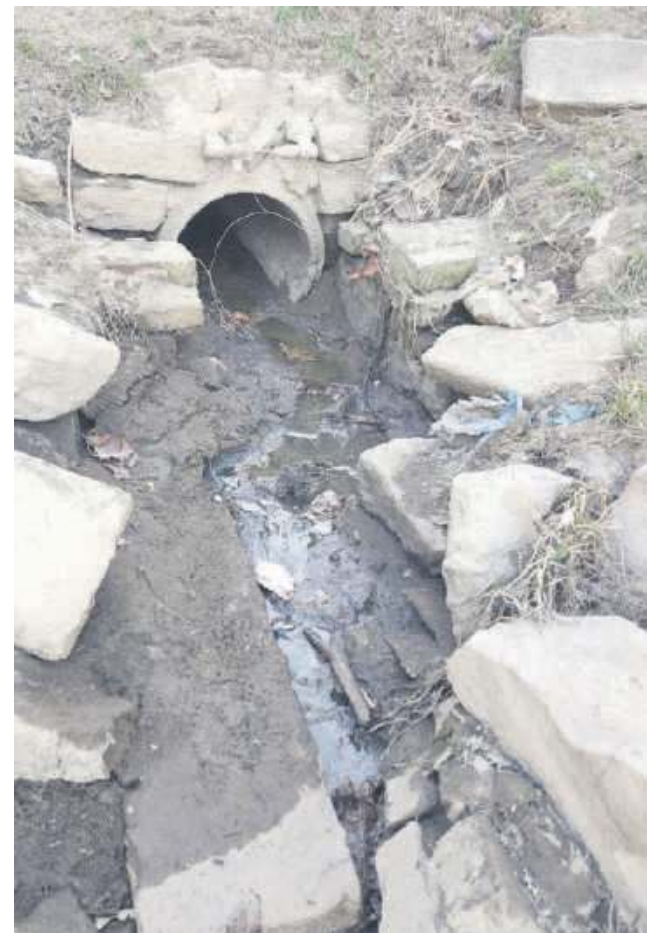
Wylot kanalizacyjny przy Odrze - to o to miejsce chodzi
