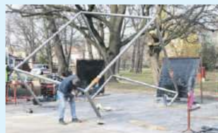
Nowa kurtyna wodna zainstalowana przy skateparku, w upalne dni pozwoli na chwilę ochłody
