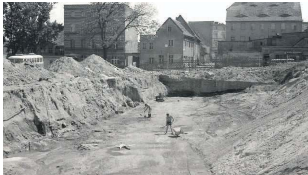
Wykopki pod blok przy ul. Jedności Narodowej - w tym miejscu biegła kiedyś miejska fosa
