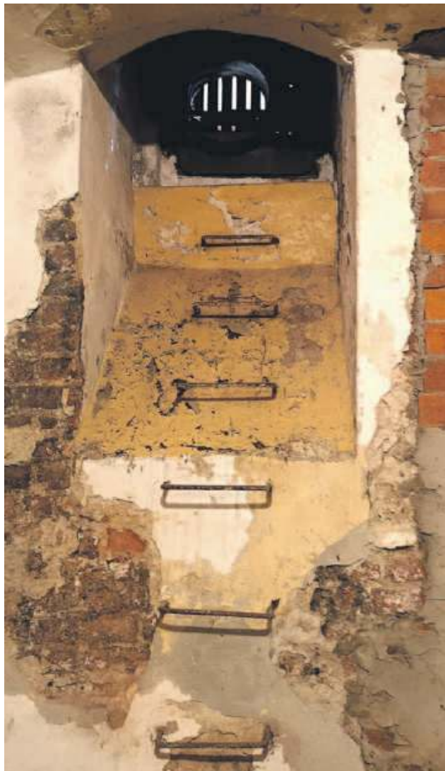
Pozostałości wyposażenia schronu pod oławskim ratuszem - są schodki do wychodzenia, gdy wejścia byłoby zasypane, jest osłonięte okienko, które zapewne kiedyś było szczelne
