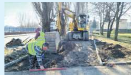
Budowa ścieżki rowerowej od ul. Rybackiej do mostu na rzece Oława przy ul. Lipowej
