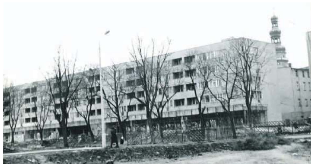
Budowa bloku przy ul. Jedności Narodowej - grudzień 1971
