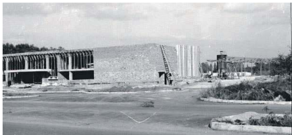
Dworzec autobusowy w trakcie budowy
