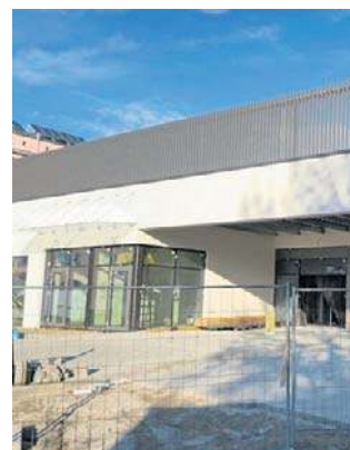
Plac budowy Szpitalnego Oddziału Ratunkowego.
