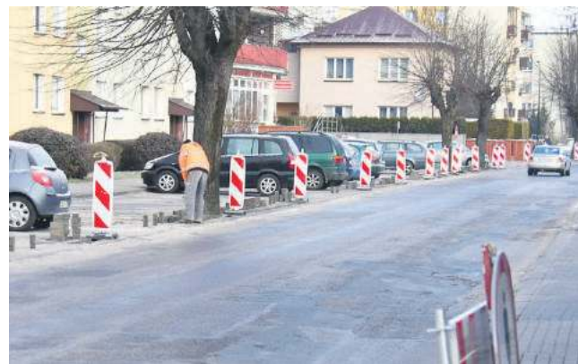
Prace potrwać do końca czerwca br.
