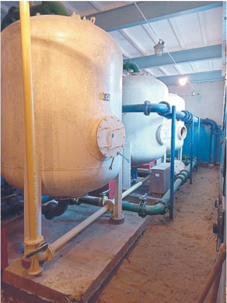
Trwa remont stacji uzdatniania wody w Piasecznie.
