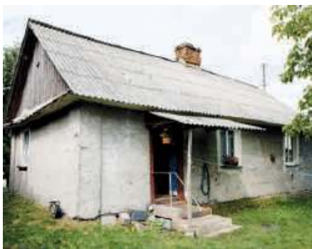
Dom przed i po remoncie
