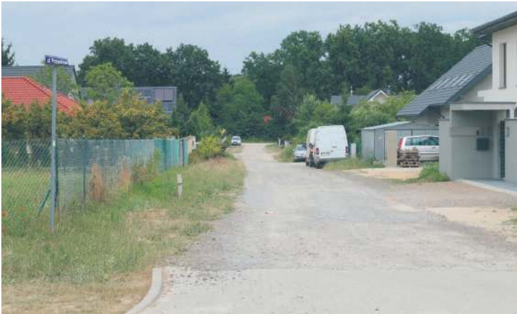
Oprócz utwardzenia 39 dróg gruntowych miasto jeszcze w tym roku rozpocznie m.in. budowę ulic Poziomkowej i Jagodowej
