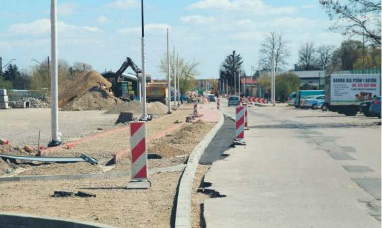
Ścieżka rowerowa wzdłuż ulicy Targowej jest już gotowa. Teraz czas na remont samej ulicy
