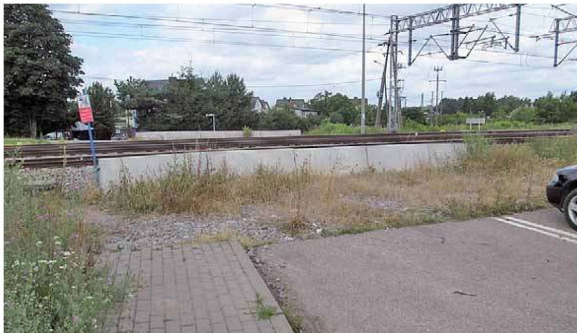
Obecny stan zamkniętego przejazdu, widok od ul. Kościuszki. Kiedy pojawi się pod nim tunel?
