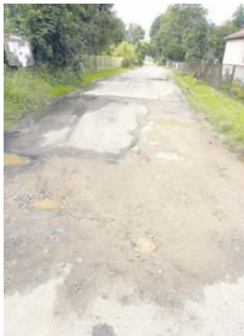
Pół roku temu były tu kilkuletni asfalt i odwodnienie z kostki brukowej.
