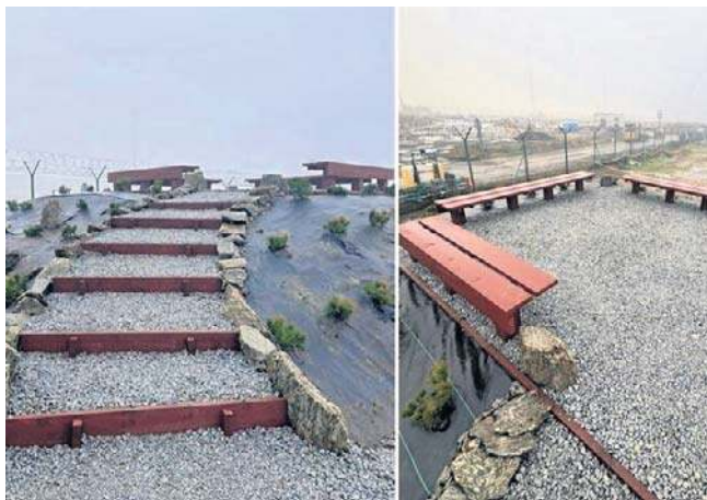
Na górze zamontowano nowe ławki oraz schodki, które ułatwiają wejście
