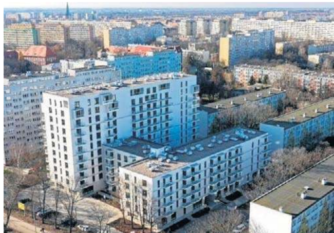
Część nadziemna kompleksu obejmuje od 5 do 11 kondygnacji i jedną podziemną
