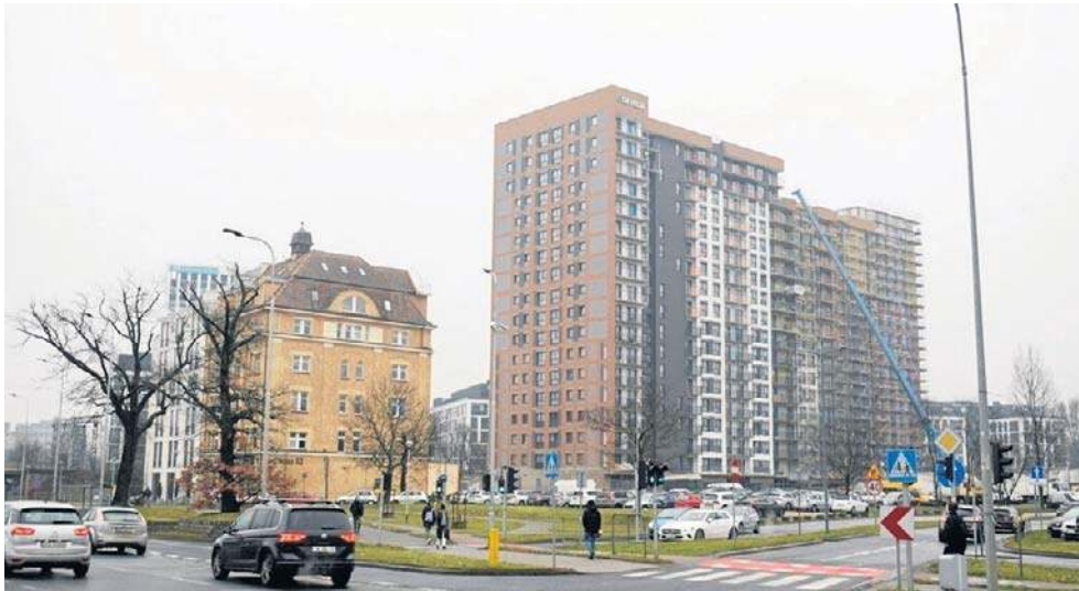
Na stronie Wrocławskie Inwestycje Budowlane zamieszczono zdjęcie budynku. Pod tą informacją posypały się nieprzychylnie komentarze
