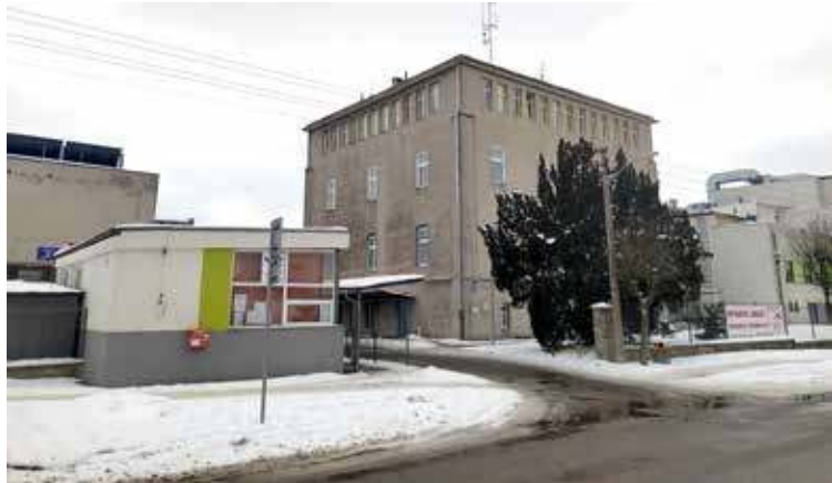
Termomodernizację ma zostać objęta stara bryła szpitala
