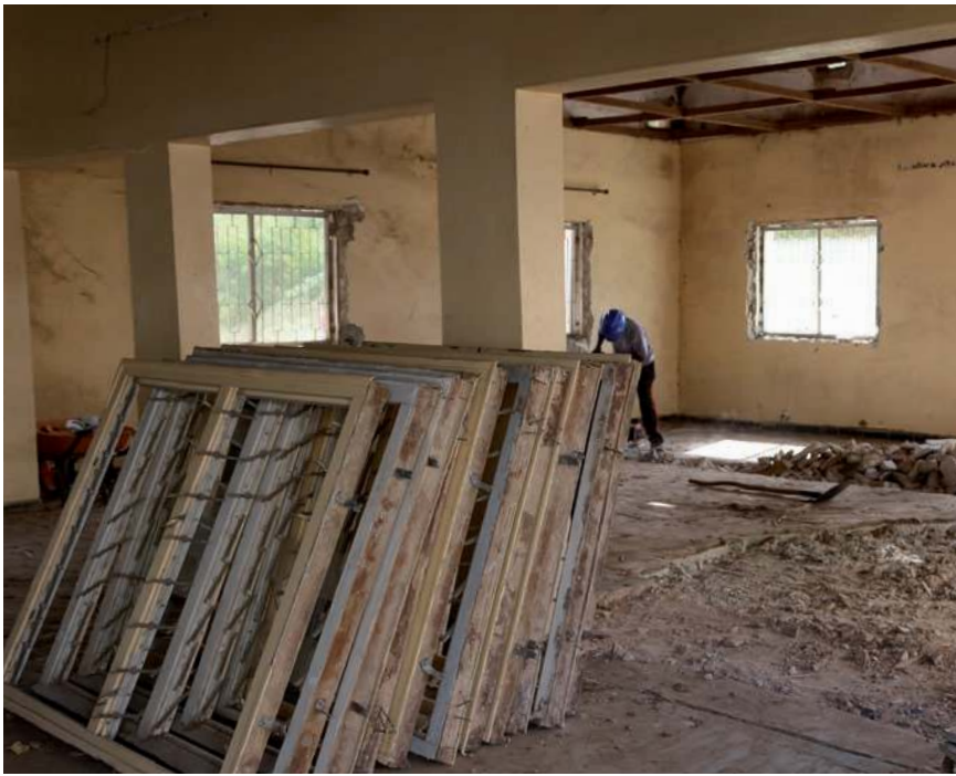
Remont kościoła w Senegalu
