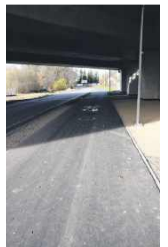
Nowa nawierzchnia drogi powiatowej
