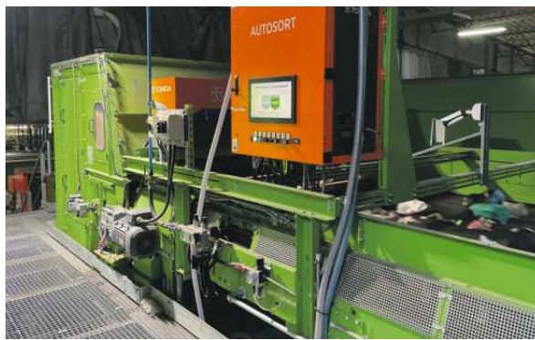
Sortownia odpadów komunalnych w ZUT Gdańsk
