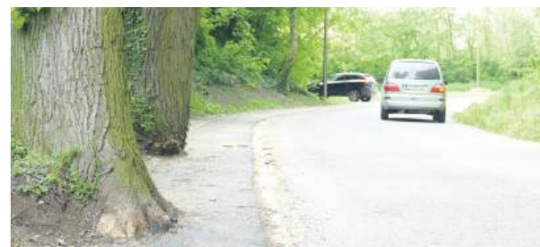
Chodnik niby jest i to asfaltowy, ale z dziecięcym wózkiem trzeba zjeżdżać na jezdnię
