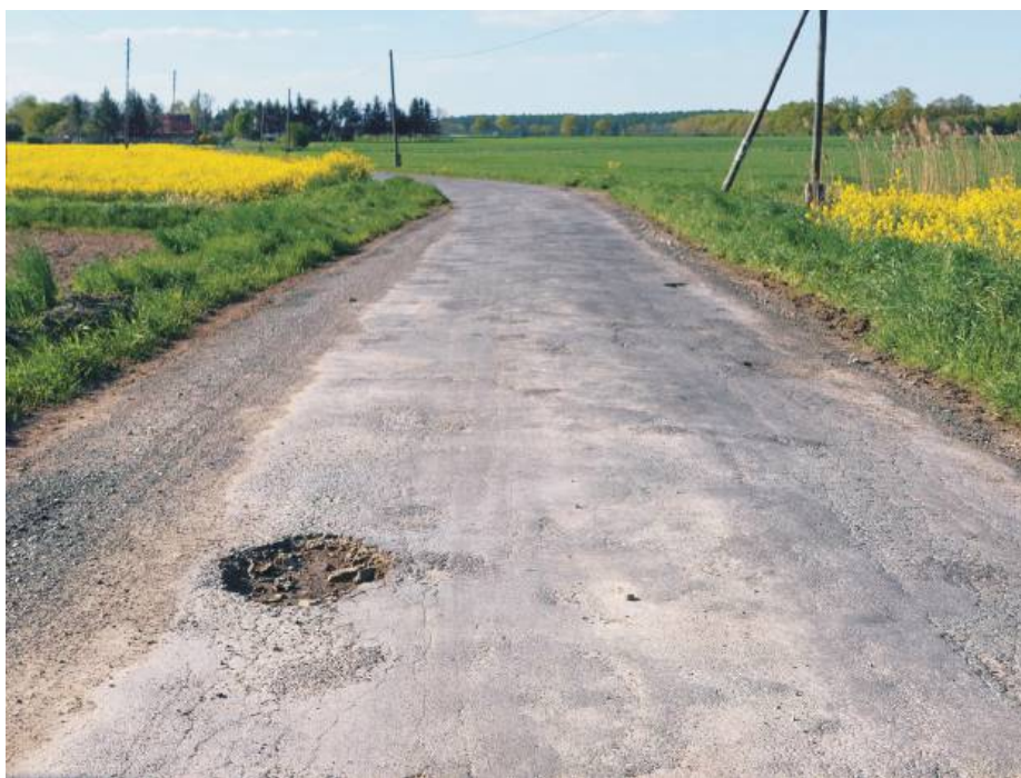
Głównym tematem ostatniej sesji Rady Gminy Przeworno było przeniesienie wydatków z kilku innych zadań na remont drogi gminnej Rożnów - Królewiec
