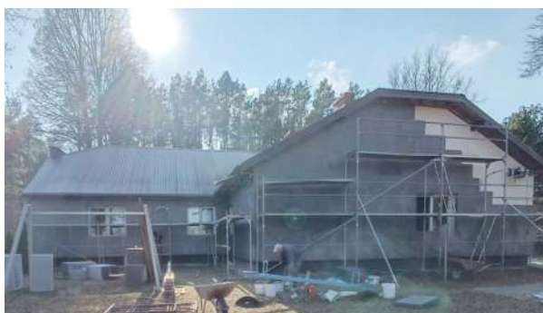
Budynek świetlicy w miejscowości Pościsz
