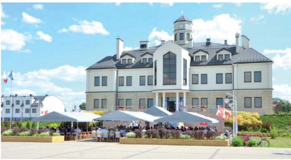
Tuż obok gmachu Urzędu Gminy (po prawej) powstał budynek przychodni (po lewej)
