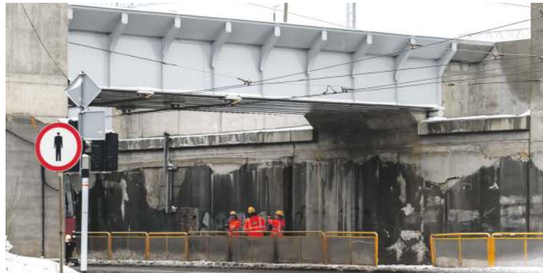
Wiadukt nabiera całkiem nowego wyglądu
