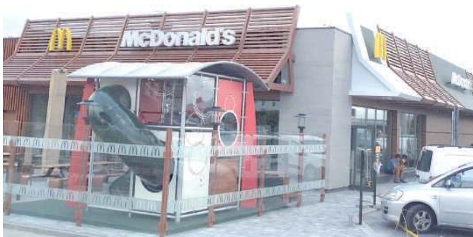
Od podstaw powstała restauracja i wjazd od ulicy Staszica. Jest też charakterystyczna dla tej sieci zjeżdżalnia dla dzieci
