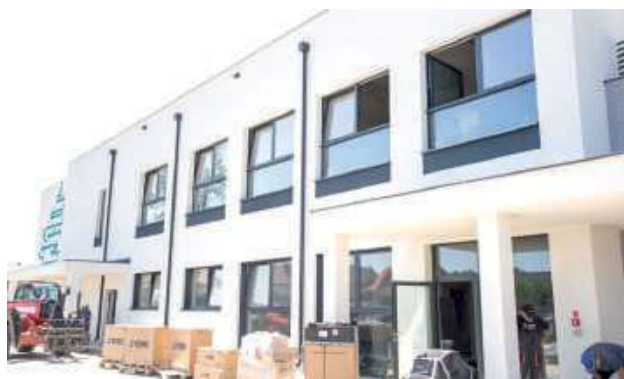
Prace przy rozbudowie SP w Jakubowicach Konińskich wkraczają w trzeci etap, wykończeniowy
