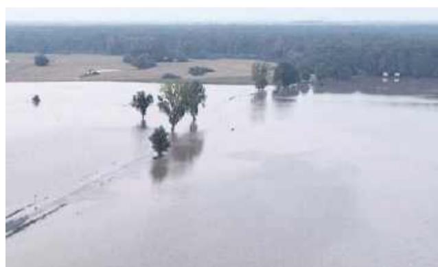
Woda z polderu Oława-Lipki dochodzi także do drogi Oława-Jelcz-Laskowice
