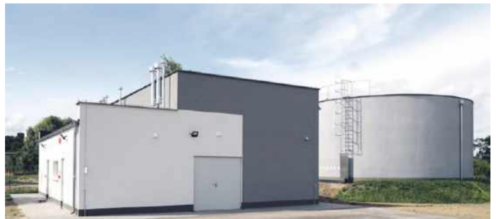
Stacja Uzdatniania Wody w Sobocisku
