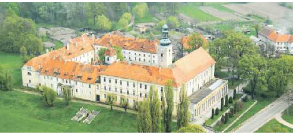
Pałac w Oleśnicy Małej
