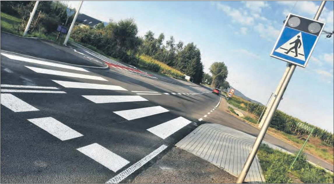
W ramach projektu Powiatu Prudnickiego zmodernizowana zostanie szosa pomiędzy Moszczanką a Pokrzywną
