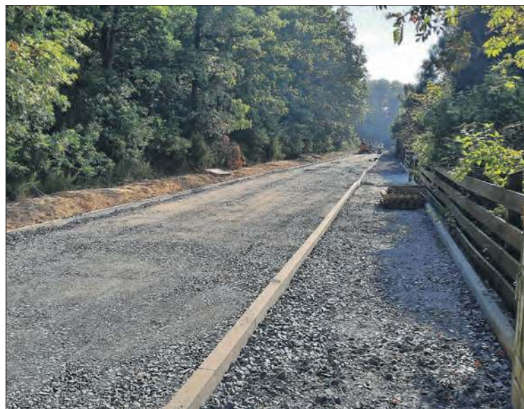
Stan prac przy budowie drogi z ubiegłego tygodnia
