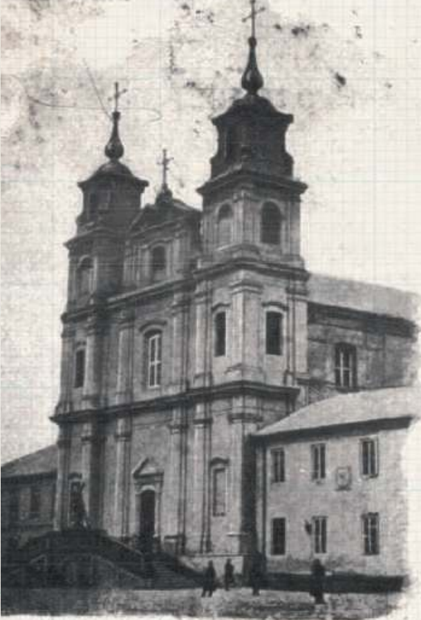
Popijarska kolegiata Przemienienia Pańskiego w Łukowie. To przy niej istniała szkoła, w której nauki pobierał Trentowski. Zdolny młodzieniec wiele zyskiwał nie tylko w ławie, ale również w czasie przechadzek z kontrowersyjnym księdzem Pułaskim, z którym toczył długie filozoficzne dysputy
