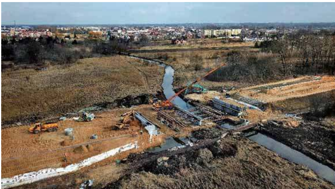
Fragment budowanej płońskiej obwodnicy z lotu ptaka
