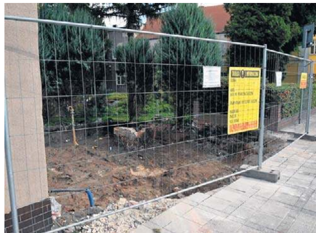
Wkrótce w tym miejscu stanie nowy obiekt, a wznowienie działalności planowane jest na grudzień.
